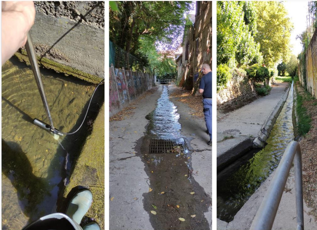
Mesures du débit de ruisseaux de la métropole et études d'anomalies (collecteurs bouchés)
