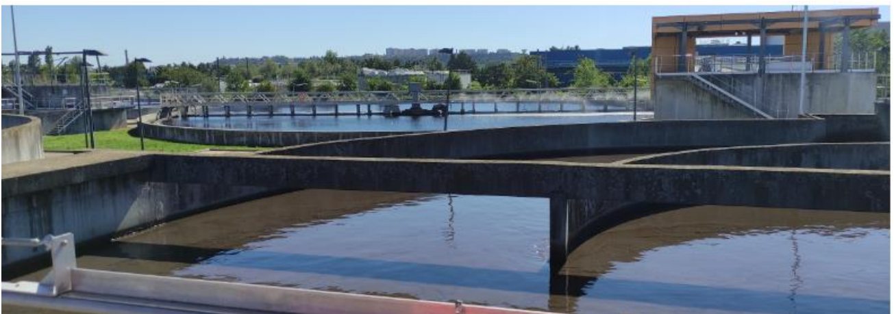
Visite de la station d'épuration de Pierre Bénite (bassin où des bactéries dégradent les éléments en suspension dans l'eau).
